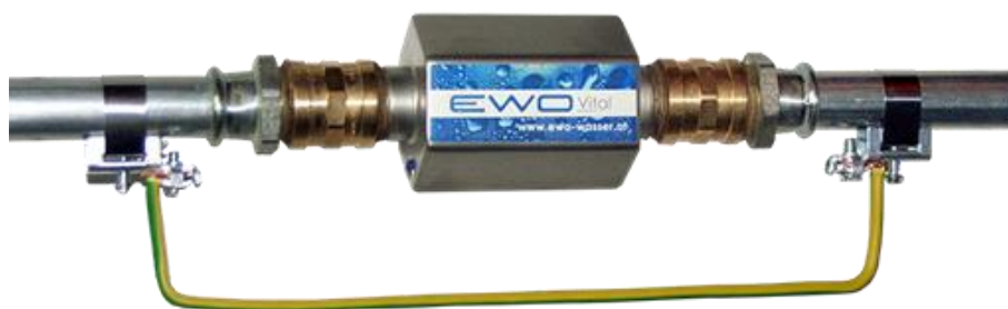
EWO vital mit korrekter elektrischer Überbrückung
